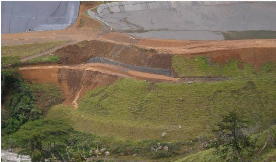
FIGURA 30 PRESA No.4- MOVIMIENTOS EN MASA SUPERFICIALES (REPTACIÓN Y DESLIZAMIENTOS SOMEROS) Y EROSIVOS SOBRE LA CARA DE LOS TALUDES Y FLUJO INTERNO QUE SE DEPOSITA EN LA PARTE BAJA.
