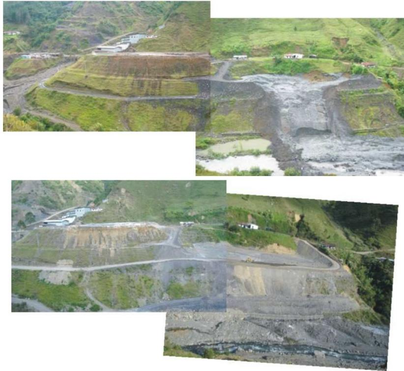
FIGURA 26: FOTOGRAFÍAS ASOCIADAS A LOS PROCESOS DE INESTABILIDAD QUE AFECTARON LA PRESA DE RELAVE EN EL AÑO 2009 Y CONSECUENTE REPARACIÓN (FOTOGRAFÍAS DEL 2009 Y 2010 RESPECTIVAMENTE)<sup>24</sup>
