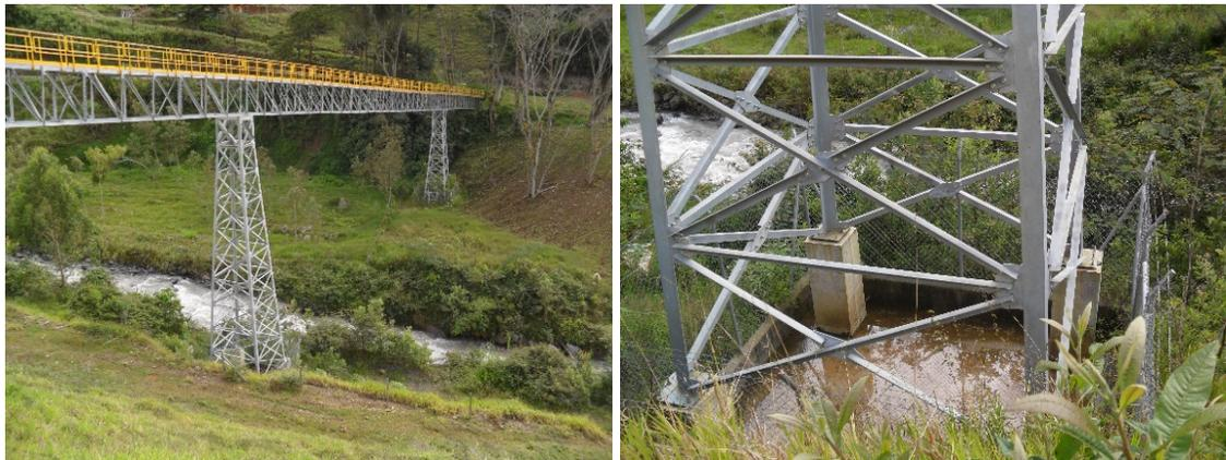
FIGURA 32. ZONA DE CRUCE DE LA TUBERÍA QUE LLEVA EL MATERIAL A LA PRESA DE RELAVE NO. 4
