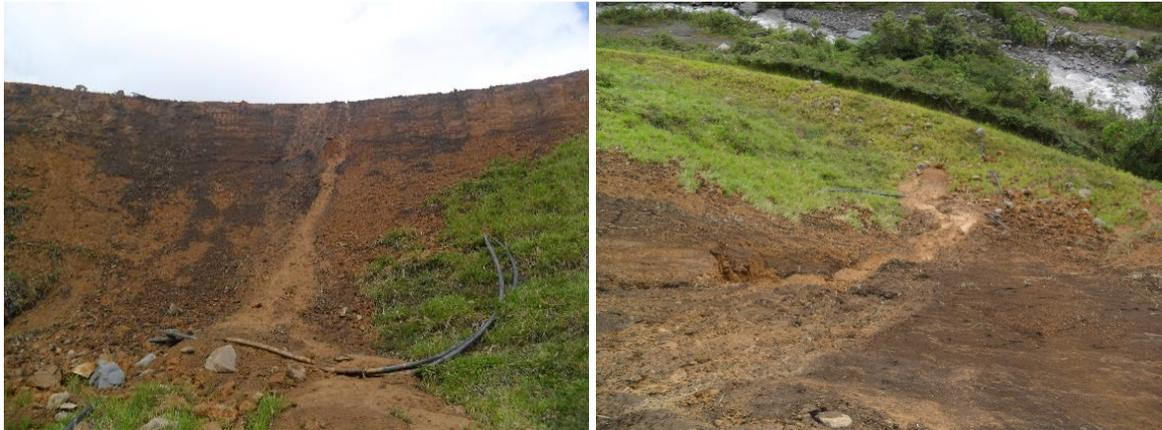
FIGURA 31 PRESA NO. 4- DETALLES DEL FLUJO INTERNO QUE AFLORA SOBRE LOS TALUDES. VISTA DESDE LA PARTE BAJA Y DESDE LA PARTE ALTA RESPECTIVAMENTE
