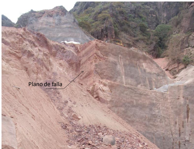
FIGURA 15. PLANO DE FALLA MESOSCÓPICA DE CARÁCTER DEXTRAL
