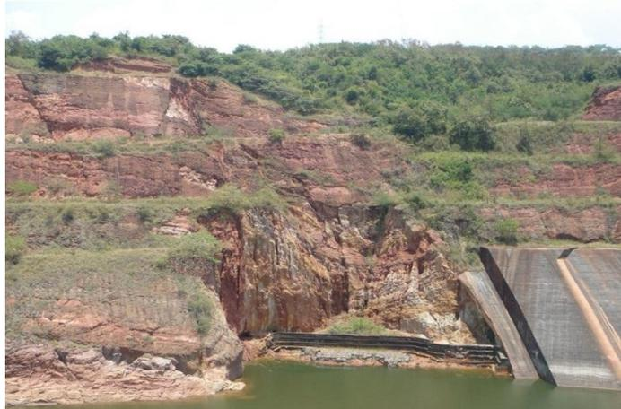
**FIGURA 21.** PROCESOS EROSIVOS EN LA PARTE BAJA DEL VERTEDERO EN LA PRESA BETANIA. ADEMÁS DE LOS CAUSADOS POR LA SOCAVACIÓN DEL AGUA QUE CAE POR EL VERTEDERO, TAMBIÉN ES MUY FUERTE LA EROSIÓN INTERNA (TUBIFICACIÓN) DE LAS ROCAS DE LA FORMACIÓN GUALANDAY. FUENTE: NOTAS DE CLASE JULIO FIERRO MORALES – GEOLOGÍA PARA INGENIERÍA.
